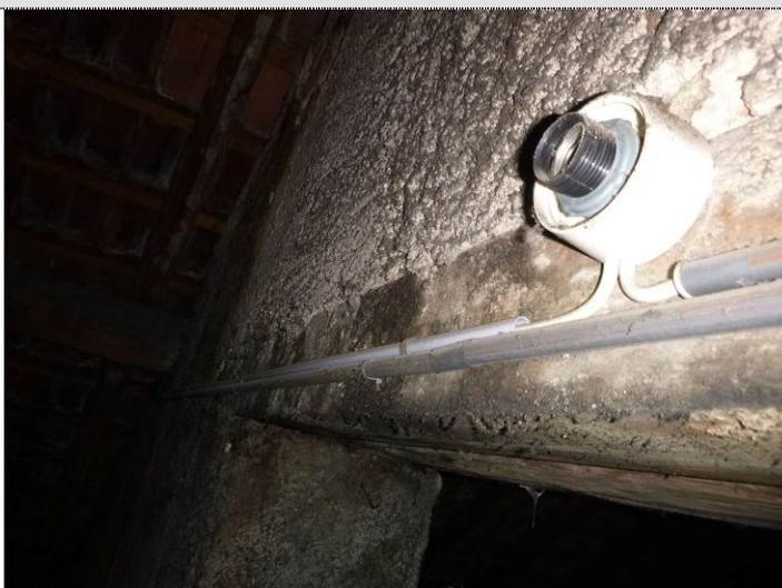
Description : Au moins un CONDUIT métalliques en montage apparent ou encastré, comportant des CONDUCTEURS, n'est pas relié à la terre.
